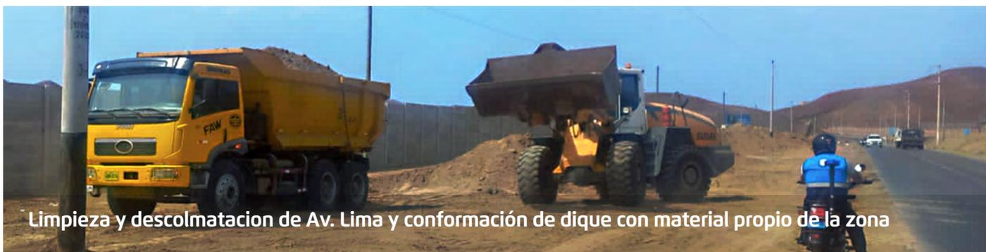
Limpeza y descolmatación de Av. Lima y conformación de dique con material propio de la zona
